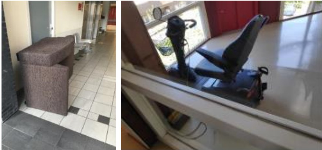
Figuur 2.5 Een bank in de gang en een scootmobiel zijn voorbeelden van spullen die volgens het Bbl niet in de vluchtroute mogen staan. Ze produceren bij brand veel rook en een scootmobiel is een mogelijke ontstekingsbron.
